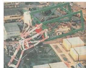
三菱重工クレーン倒壊
